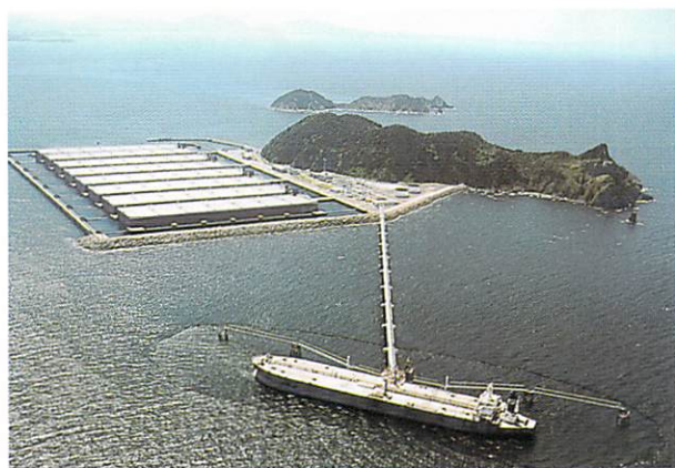
若松区沖の響灘に建設された白島石油備蓄基地
